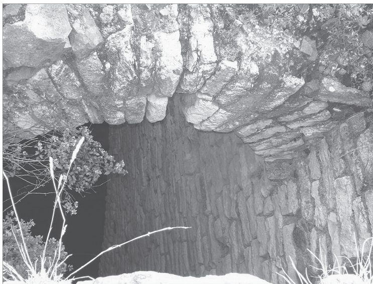
Figura 3. Tiro de mina forrado con mampostería
