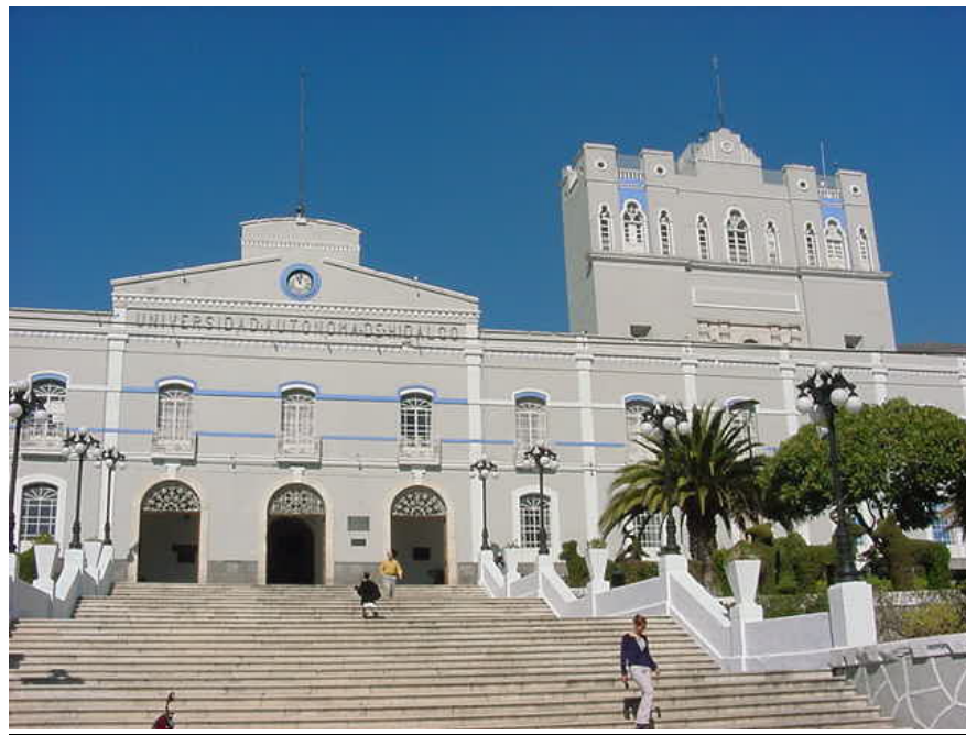
Entrada principal del edificio de la Rectoría UAEH, Pachuca, Hidalgo.
