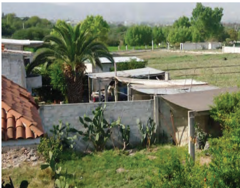
Vivienda común de la localidad
