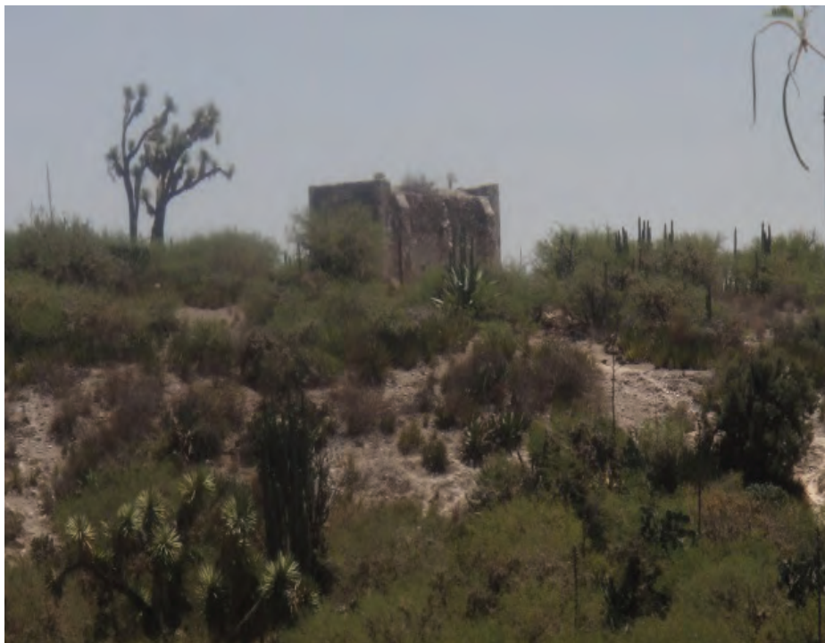
Capilla ubicada frente a la localidad
