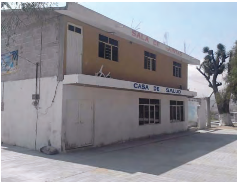
Casa de salud y sala de juntas
