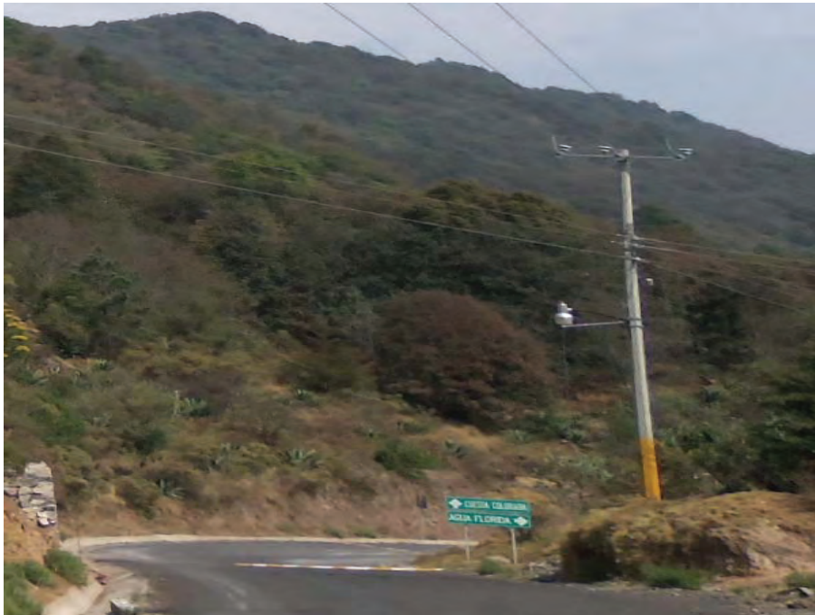
Acceso principal a la localidad
