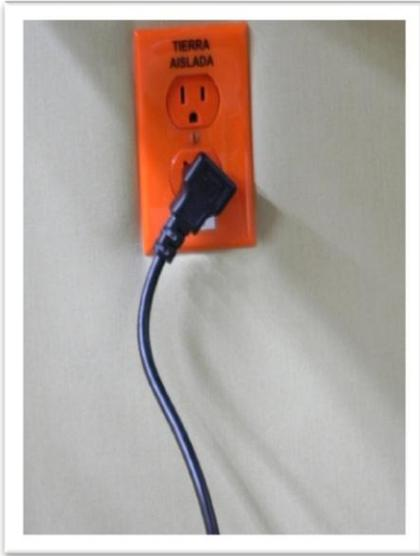
Desconectar no brake de la energía eléctrica
